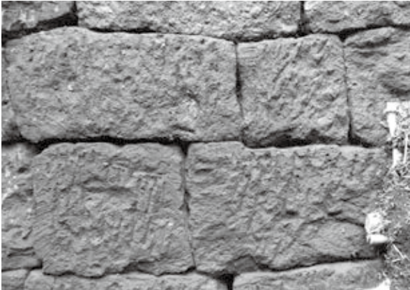
石材の「現場合わせ」と「割り込み」
