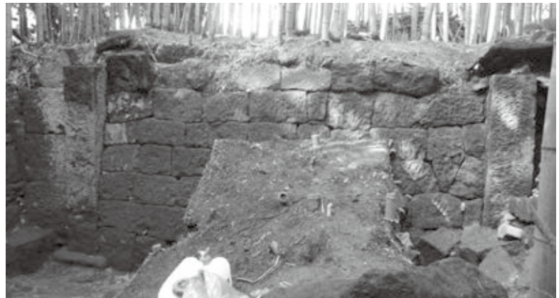
石造建物 西側壁の構築状況(東から)
